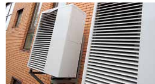
ЧАСТНЫЙ КОТТЕДЖ, Г. ДНЕПРОПЕТРОВСК
