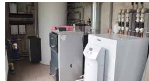
КОТТЕДЖ, ПГТ НИКОЛАЕВКА
