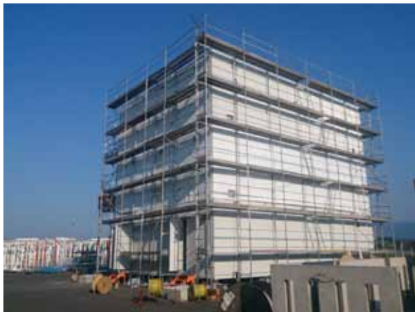
Рис. 1. Процесс создания модульного дата-центра на фабрике Emerson в Хорватии
