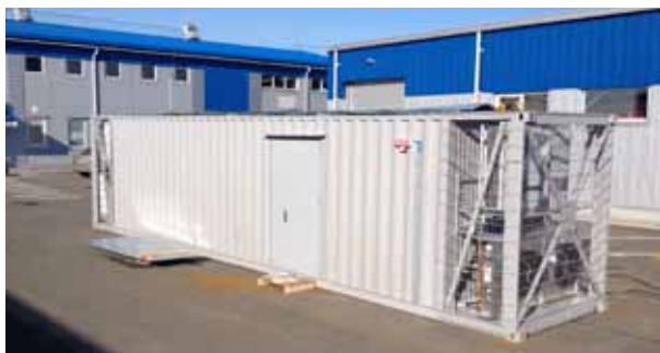
Рис. 2. Первый украинский коммерческий МЦОД; внешние блоки кондиционеров не выступают за пределы 12-метрового контейнера
