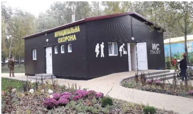
Нові службові приміщення
