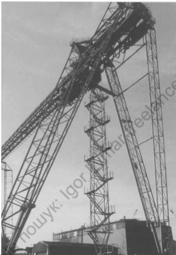
Мал. 18. Незалежна від опор сходові шахта
