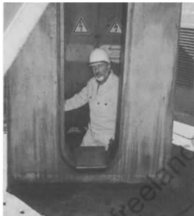
Мал. 9. Безпечний доступ через нерухому опору поворотного крана
