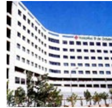
Hospital 9 de Octubre (VALENCIA)
