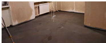
ОБЪЕКТ ПО СТЯЖКЕ ПОЛА И ШТУКАТУРКЕ НА ГРАЖДАНСКОМ ПРОСПЕКТЕ
