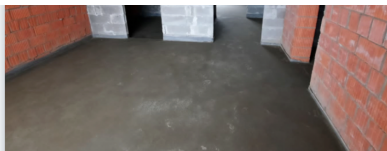
ОБЪЕКТ ПО СТЯЖКЕ ПОЛА В КП ГЕНЕРАЛЬСКАЯ ДАЧА
