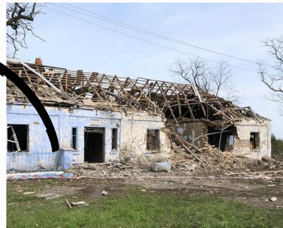
Адмінбудівля в м. Снігурівка, січень 2023.
