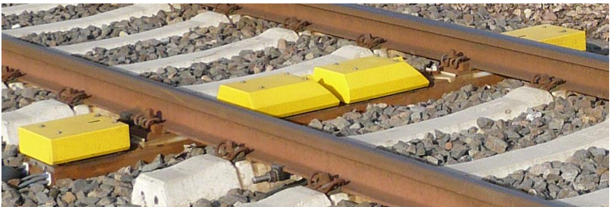
Рисунок 3.1.1 – Датчики ПОНАБ
